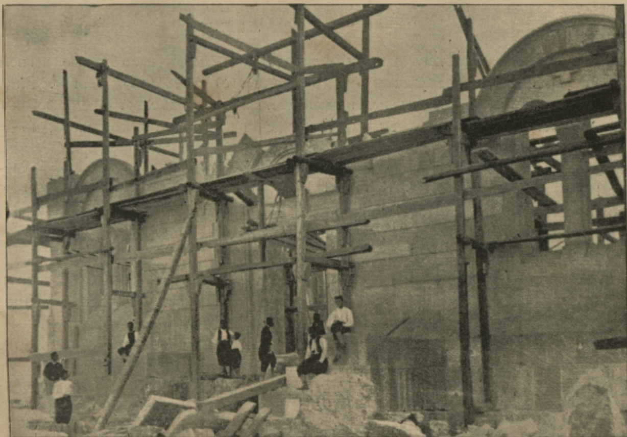
Строющійся въ Никшичѣ соборъ.
